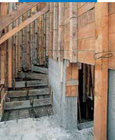
Przykłady deskowania przy użyciu Disarmante DMA 1000
