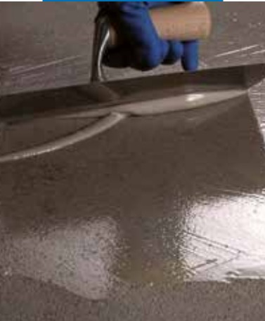
Gruntowanie podłoża
