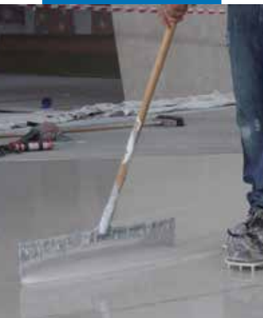
Nakładanie masy samopoziomującej
