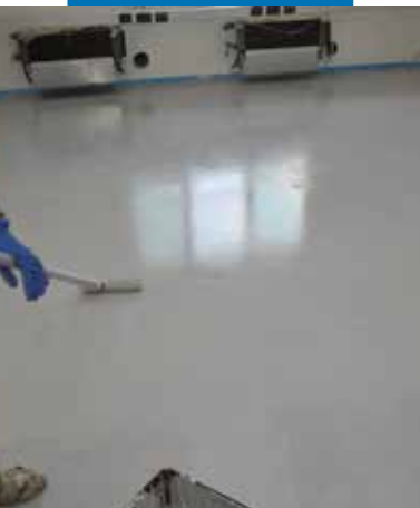
Zabezpieczanie powierzchni i woskowanie
