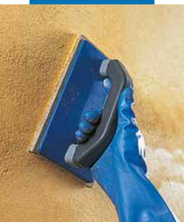
Wykańczanie Silexcolor Tonachino SP pacą z tworzywa sztucznego
