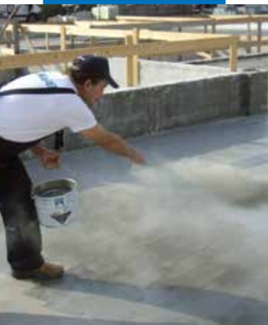
Sprinkling Quartz 0.5 on fresh Primer SN
