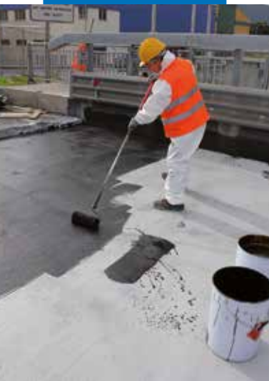
Rozprowadzanie warstwy Purtop Primer Black
