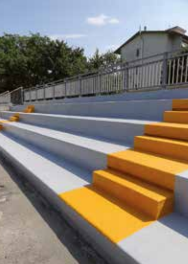
Trybuny pokryte hydroizolacją z Purtop 400 M pokrytym warstwą zamykającą Mapefloor Finish 55
