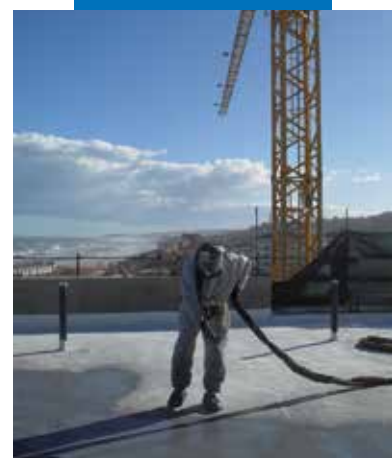
Aplikacja warstwy Purtop 400 M na warstwę Triblock P
