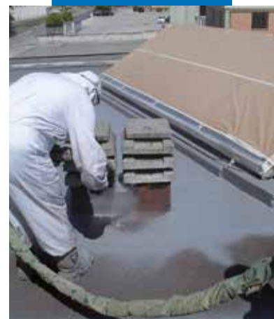
Aplikacja warstwy Purtop 400 M na powłokę bitumiczną
