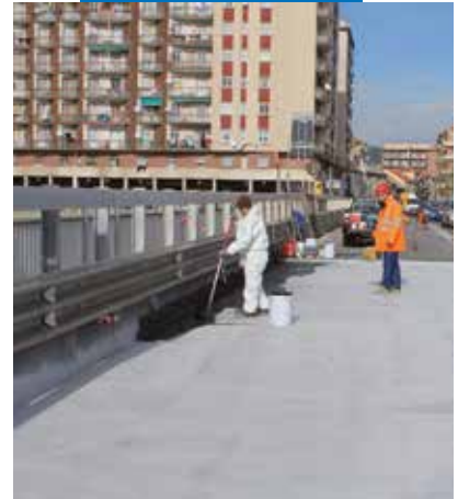
Application of Purtop Primer Black
