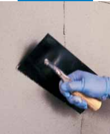
Nanoszenie Planitop 560 metalową pacą
