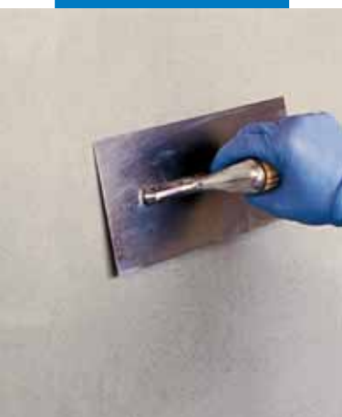
Wyglądanie powierzchni wykonanej z Planitop 560 przy pomocy metalowej pacy
