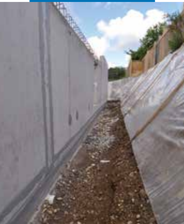
Uszczelnianie dylatacji konstrukcyjnych ściany fundamentowej
