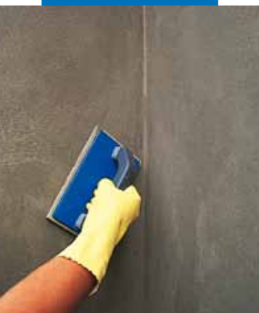
Wykańczanie za pomocą zacieraczki z gąbką
