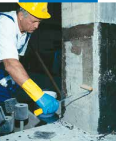
Applying MapeWrap Primer 1
