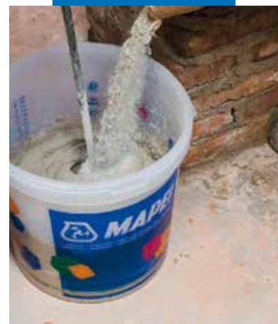
Preparing MapeWall Muratura Fine
