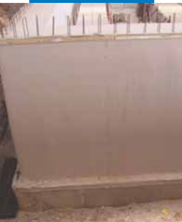
Uszczelnianie pionowej powierzchni po odlewaniu
