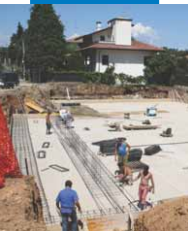
Uszczelnianie fundamentów domu
