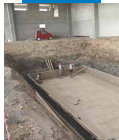
Uszczelnianie poziomej powierzchni przy użyciu Mapeproof
