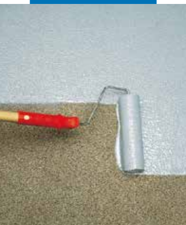
Aplikacja Mapecoat I 24 za pomocą wałka
