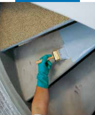
Aplikacja Mapecoat I 24 na podłożu betonowym
