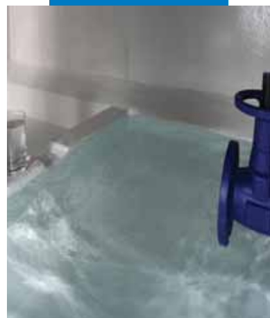
Napełnianie zbiornika po całkowitym wyschnięciu Mapecoat DW 25
