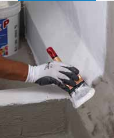
Nanoszenie preparatu Triblock P na wilgotne podłoże
