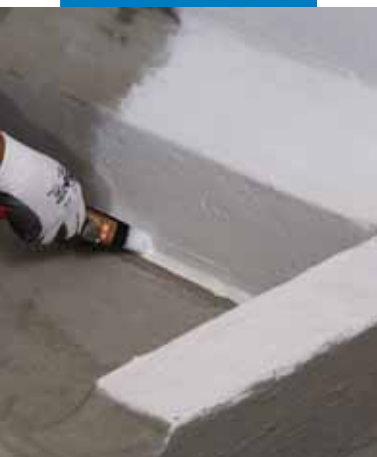
Aplikacja Triblock P w szczelinę w celu utworzenia połączenia pomiędzy płytą posadzki a ścianą pionową
