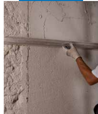
Levelling off Mape-Antique MC Macchina with a straight edge
