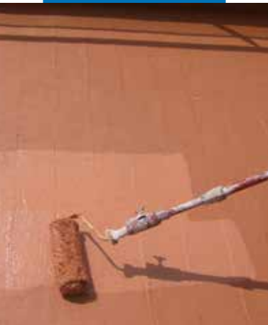
Nakładanie warstwy Aquaflex Roof wałkiem z długim włosiem
