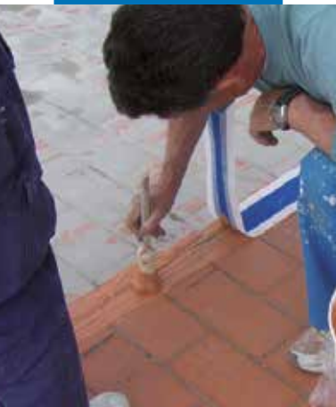
Uszczelnianie dylatacji taśmą Mapeband przyklejoną do podłoża Aquaflex Roof
