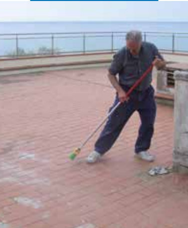
Przygotowanie podłoża przed aplikacją Aquaflex Roof
