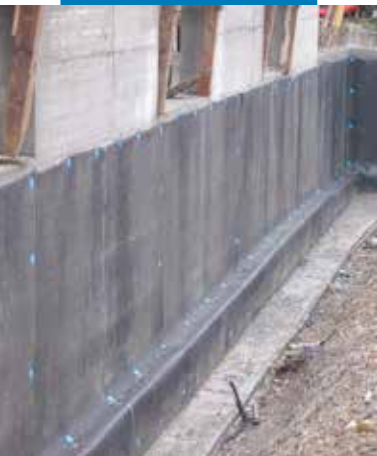
Hydroizolacja powierzchni pionowej z użyciem Mapeproof PL
