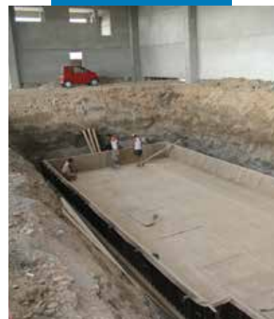
Hydroizolacja powierzchni poziomej z użyciem Mapeproof PL
