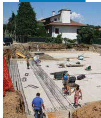
Hydroizolacja fundamentów budynku
