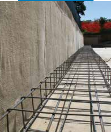
Hydroizolacja płyty dennej
