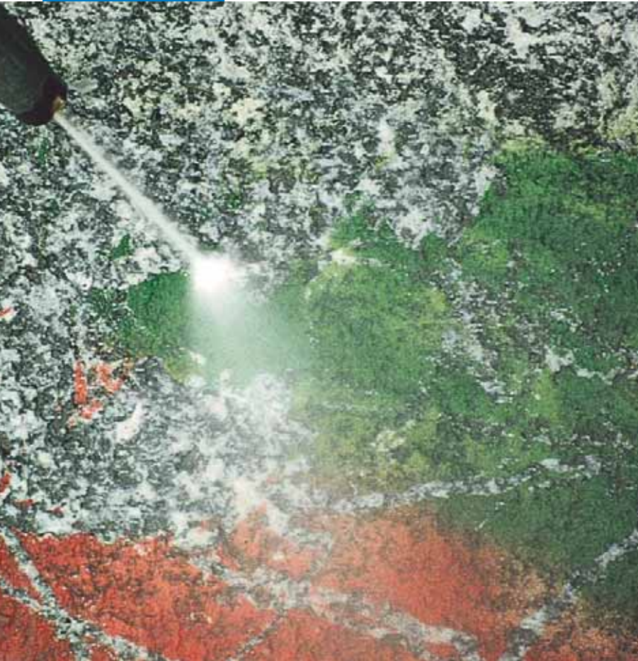
Czyszczenie granitu, na którym zastosowano WallGard Graffiti Barrier, wodą pod wysokim ciśnieniem
