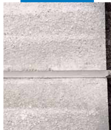
Końcowy wygląd złącza po usunięciu taśmy
