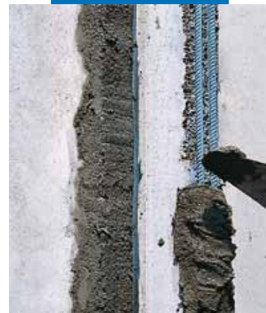
Nakładanie zaprawy przy użyciu kielni
