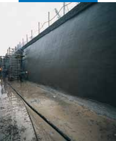
Kanał hydroelektryczny Bertini - Robbiate (Como). Widok ogólny
