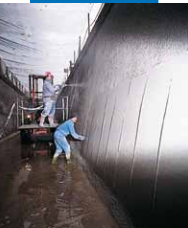
Kanał hydroelektryczny Bertini - Robbiate (Como). Profilowanie przy użyciu pacy
