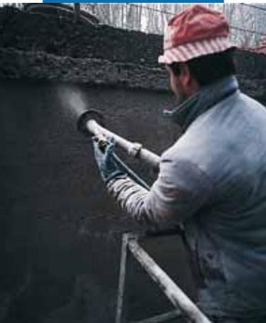
Kanał hydroelektryczny Bertini - Robbiate (Como). Nakładanie zaprawy metodą natryskową
