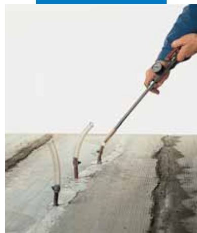
Naprawa elementu poziomego poprzez iniekcję Epojet
