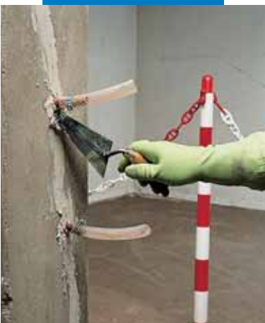
Mocowanie pakerów iniekcyjnych z zastosowaniem Adesilex PG1
