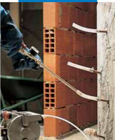
Iniekcja preparatu Epojet w zarysowanym pilastrze
