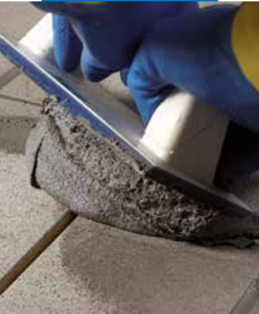
Nakładanie Kerapoxy CQ pacą MAPEI
