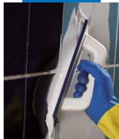
Nakładanie Kerapoxy CQ pacą MAPEI
