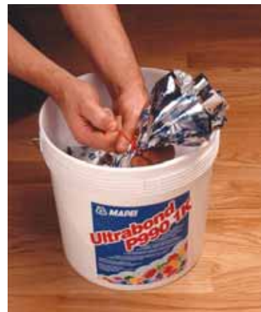
Uszczelnienie aluminiowego worka przy pomocy specjalnej taśmy umieszczonej w wiaderku
