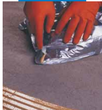
Metoda alternatywna użycia opakowania: nacięcie worka w dolnym rogu
