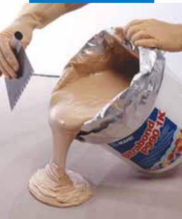
Wylewanie kleju na podłoże
