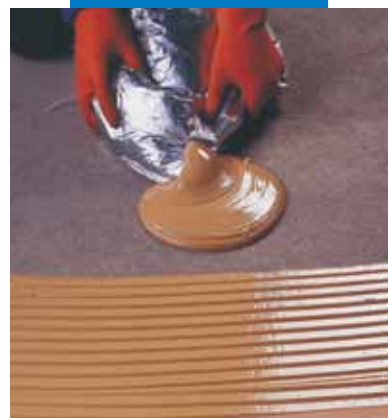
Wyciskanie kleju z opakowania naciętego w dolnym rogu
