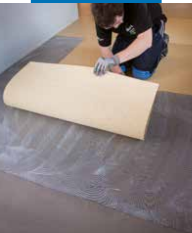
Montaż wykładziny gumowej w płytkach
