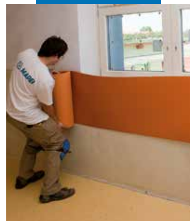
Montaż arkusza gumowej okładziny na ścianie
