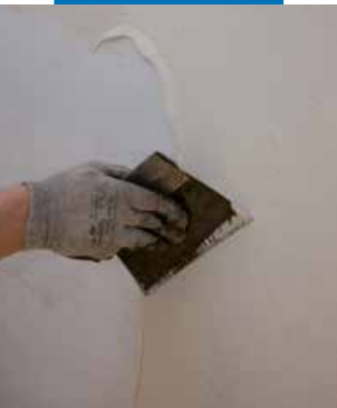
Rozprowadzanie Ultrabond Eco V4 SP Fiber na ścianie
