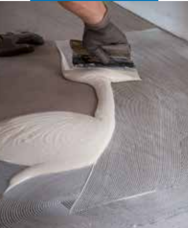
Rozprowadzanie Ultrabond Eco V4 SP Fiber na podłożu
