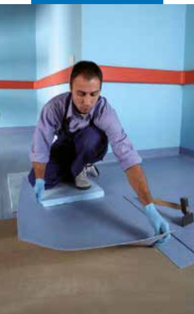
Montaż arkuszy wykładziny winylowej
