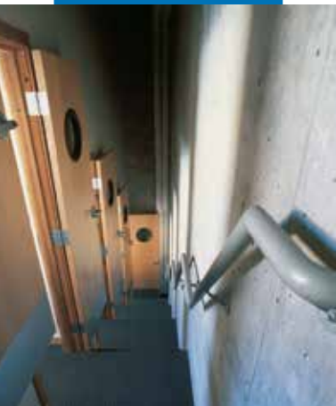
Przykład montażu wykładziny dywanowej na schodach wieży sędziów skoczni narciarskiej w Salt Lake City 2002 (USA)
