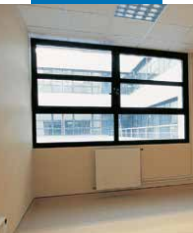
Przykład montażu wykładziny PVC w szpitalu Montluçon (Francja)
