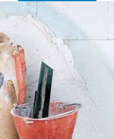
Zastosowanie środka gruntującego Primer G na tynki gipsowe
