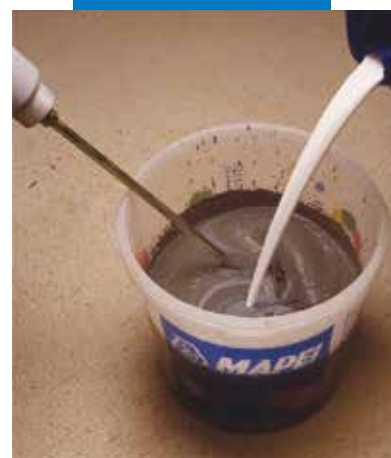
Mieszanie Planipatch z Latex Plus w celu wyglądania trudnych i odkształcalnych podłoży
