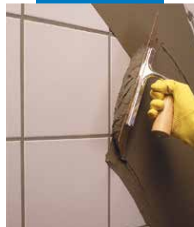
Wyglądanie istniejącej okładziny z użyciem Planipatch
