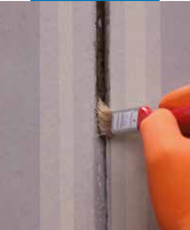
Aplikacja preparatu gruntującego Primer M
