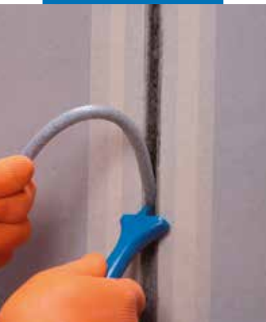
Umieszczanie w szczelinie dylatacyjnej sznura z pianki polietylenowej Mafoam
