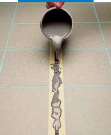
Sposób wypełniania szczelin masą Mapeflex 21
