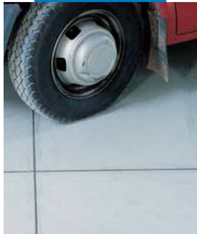
Spoiny dylatacyjne w posadzce betonowej, wykonane przy użyciu masy Mapeflex PU21
