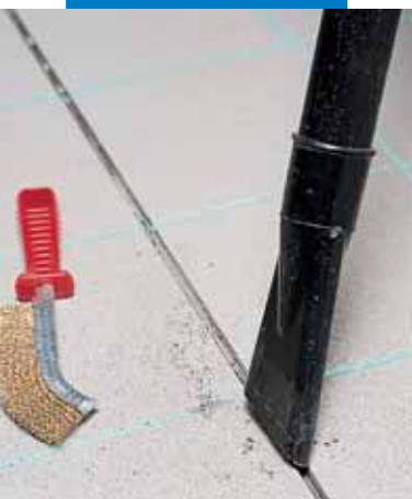
Czyszczenie szczeliny odkurzaczem
