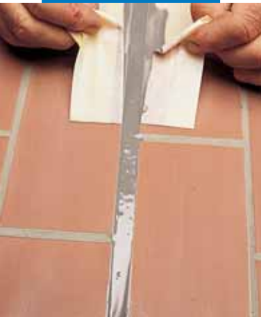
Spoinowanie szczeliny dylatacyjnej masą Mapeflex PU21
