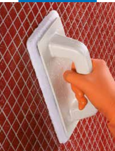
Wstępne czyszczenie powierzchni mozaiki szklanej pacą typu ScotchBrite®
