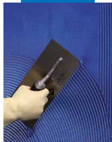
Nakładanie pacą zębatą zaprawy klejącej Kerapoxy Design w kolorze niebieskim
