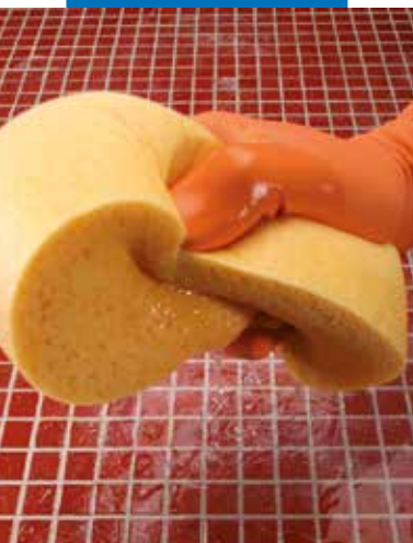
Zwilżanie wodą zaspoinowanej powierzchni przed czyszczeniem
