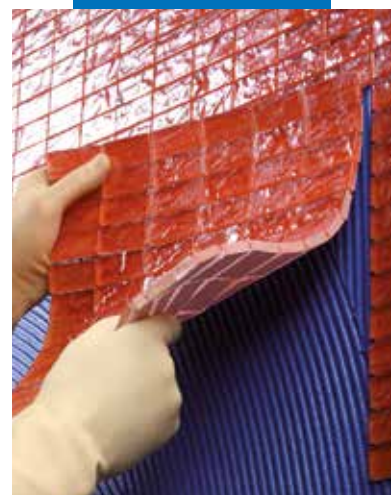
Układanie mozaiki szklanej na ścianie
