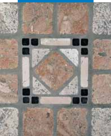
Przykład wykonanych spoin na podłożu z kamienia naturalnego
