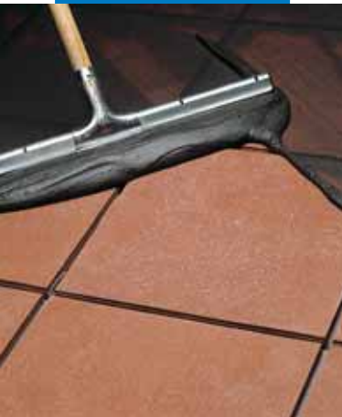
Spoinowanie płytek typu cotto przy użyciu rakli
