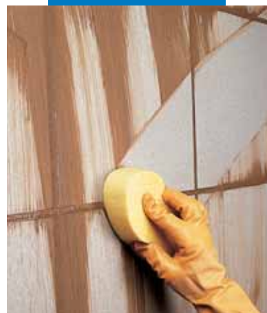
Czyszczenie płytek przy użyciu gąbki
