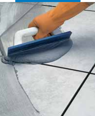
Spoinowanie podłogi ceramicznej przy użyciu pacy gumowej
