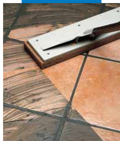
Czyszczenie płytek typu monocottura przy użyciu rakli z gąbką
