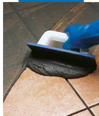
Spoinowanie płytek gumową pacą
