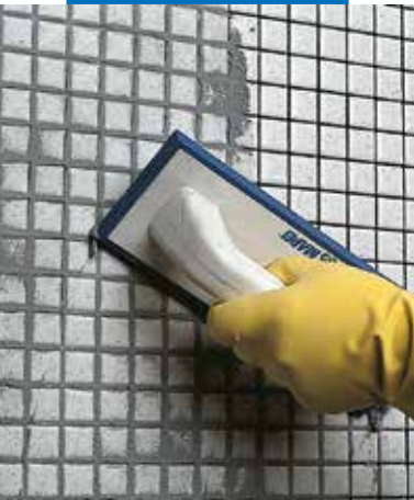
Spoinowanie mozaiki szklanej pacą
