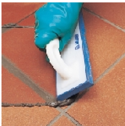
Nakładanie FUGOLASTIC na zniszczoną fugę
