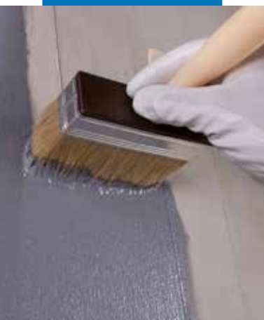
Nakładanie Eco Prim Grip pędzlem na powierzchnię betonową
