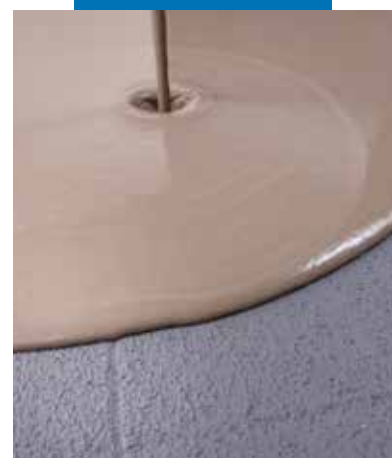
Rozprowadzanie masy samopoziomującej Ultraplan na suchy Eco Prim Grip naniesiony na starą okładzinę
