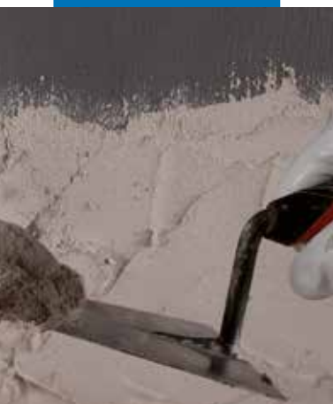
Nanoszenie tynku na Eco Prim Grip
