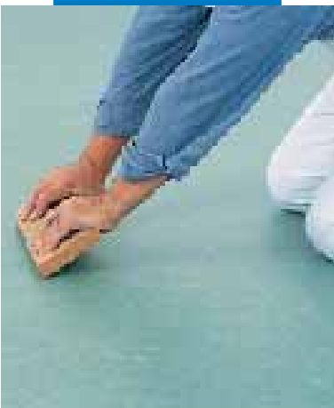
Wygładzanie złącza na wykładzinie z linoleum
