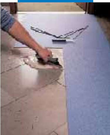
Montaż PVC na podłożach niechłonnych przy użyciu Adesilex G19
