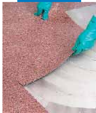
Montaż wykładziny PVC przy użyciu Adesilex G19
