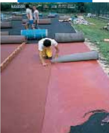
Montaż wykładziny Sportflex Super przy użyciu Adesilex G19
