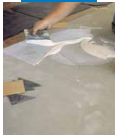
Przykład montowania PCW na masę szpachlową Ultra
