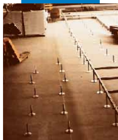
Podłoże wrównane przy użyciu Ultraplan
