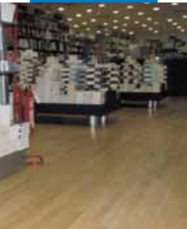
Przykład montażu drewna na masie samopoziomującej Ultraplan
