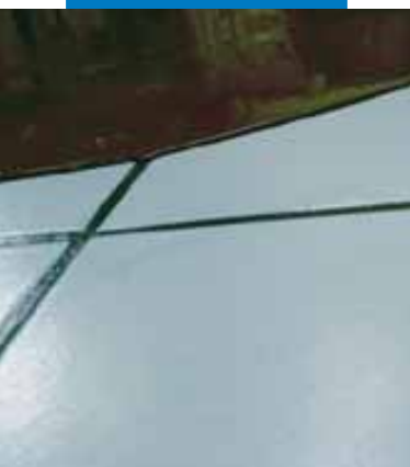
Rozpływ masy Ultraplan na starym podłożu ceramicznym wcześniej zagruntowanym Mapeprim SP
