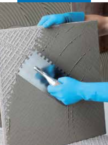
Rozprowadzanie kleju na spodniej stronie płytki
