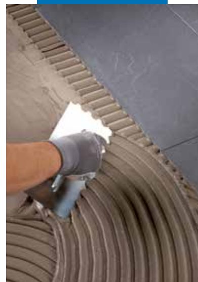
Rozprowadzanie kleju na posadźce za pomocą pacy z okrągłym zębem
