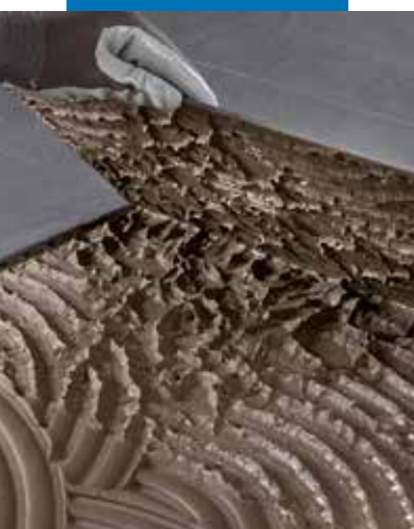
Prawidłowe wypełnienie spodniej strony płytki z gresu porcelanowego
