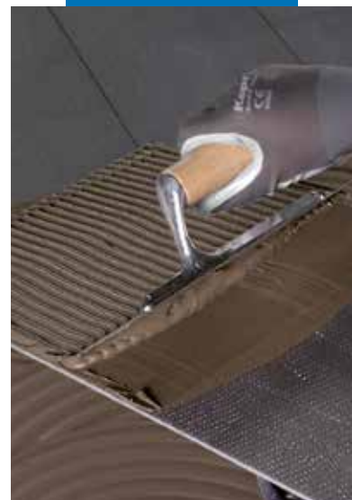
Rozprowadzanie kleju na spodniej stronie płytki
