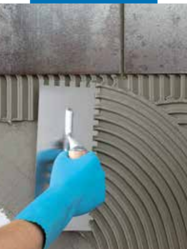
Rozprowadzanie Ultralite S1 pacą zębatą na ścianie
