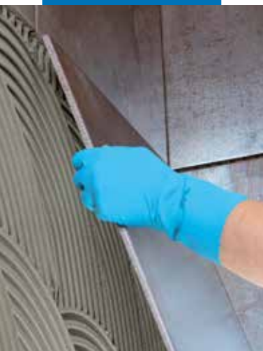
Montaż płytek wielkoformatowych na ścianie
