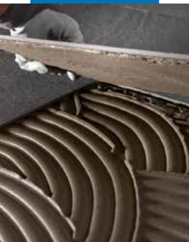
Montaż cienkiej płytki z gresu porcelanowego na podłodze
