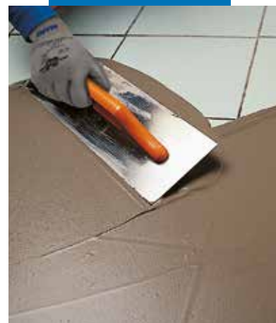
Wyrównywanie istniejącej podłogi przy użyciu Nivorapid
