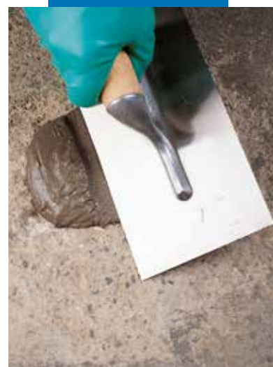
Naprawa poziomej krawędzi przy użyciu Nivorapid
