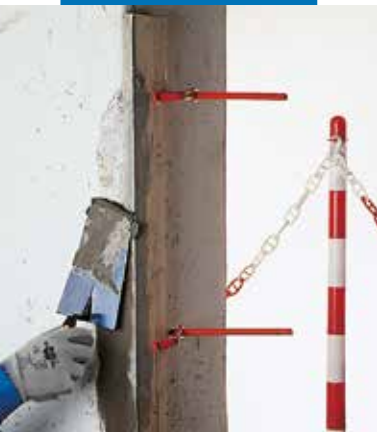
Naprawa pionowego narożnika zaprawą Nivorapid
