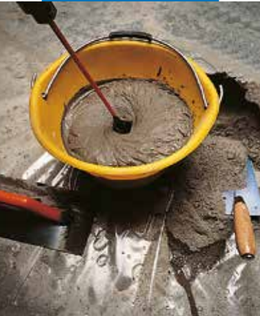
Mieszanie zaprawy Nivorapid za pomocą mieszadła wolnoobrotowego
