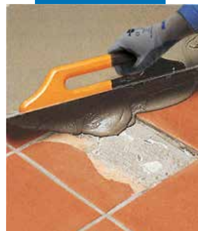
Wypełnianie ubytków przy pomocy Nivorapid
