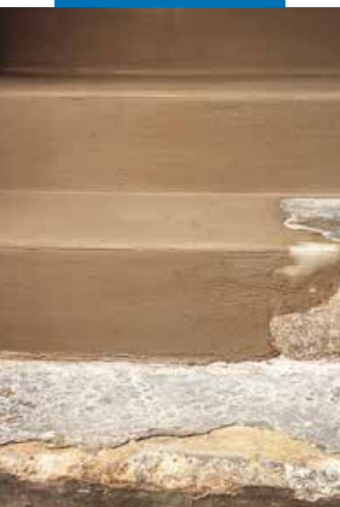
Stopnie schodów przed i po zastosowaniu Nivorapid
