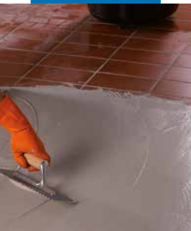
Nakładanie drugiej warstwy Monolastic na Mapenet 150
