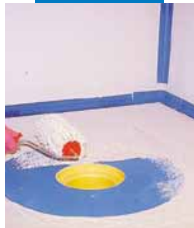
Specjalny fragment taśmy Mapeband pokrywa się warstwą Mapegum WPS
