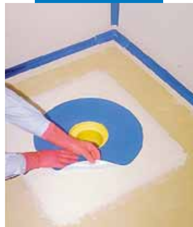
Montaż specjalnej taśmy Mapeband na Mapegum WPS
