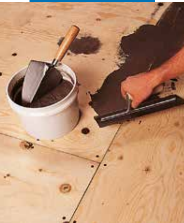
Szpachlowanie podłoża ze sklejk przy użyciu zaprawy Nivorapid zmieszanej z Latex Plus
