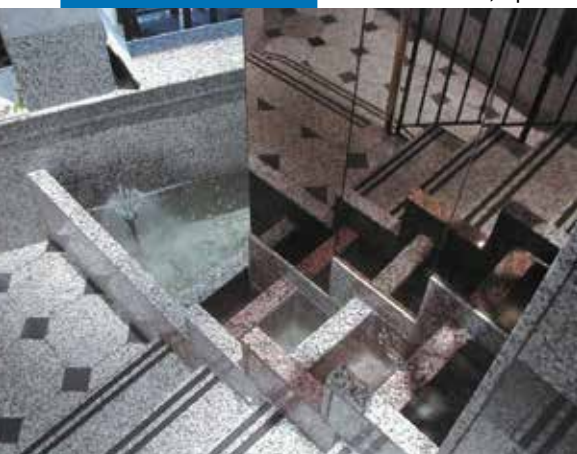
Przykład montażu granitu na ścianie i podłodze, gdzie do kleju dodano Latex Plus - Caesaris Palace, Merseyside - Liverpool (Wielka Brytania)
