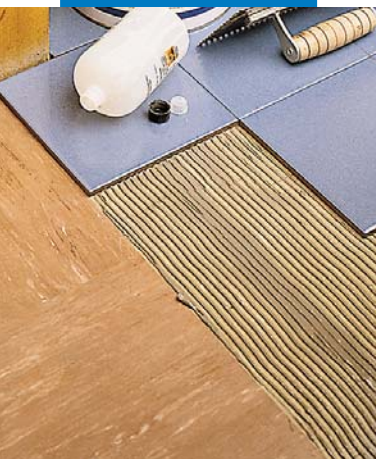
Nakładanie na stare podłoże z PVC
