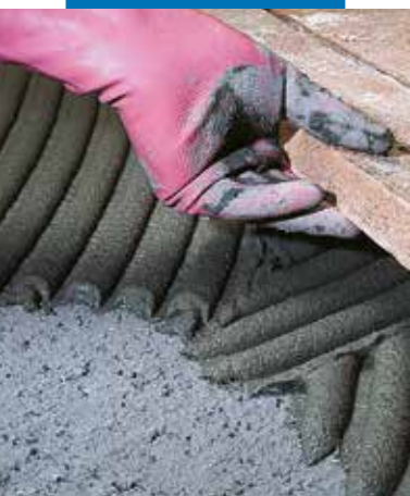
Układanie ręcznie wykonanej terakoty na nierównym podłożu
