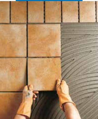
Montaż płytek klinkierowych na zewnątrz
