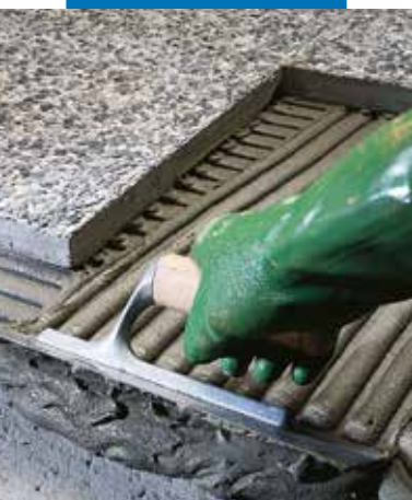
Montaż lastryko na zewnątrz
