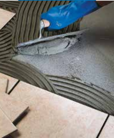
Montaż płytek typu monocottura na podłodze
