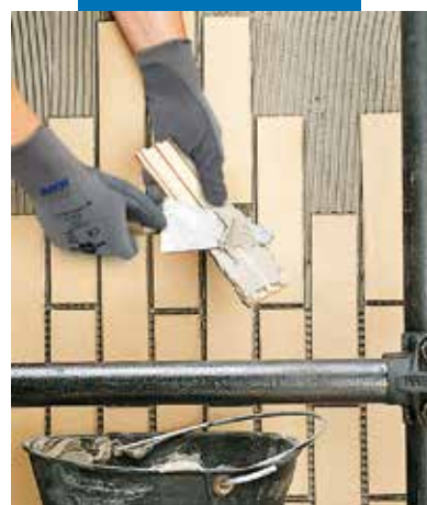
Zaprawą należy pokryć całą powierzchnię płytki
