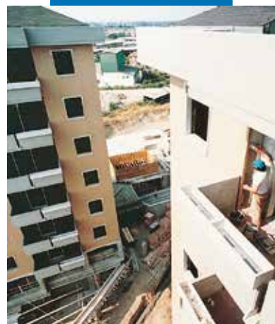
Montaż płytek na zewnątrz
