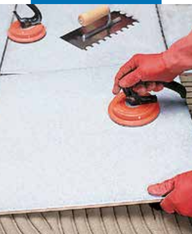
Montaż płytek dużego formatu
