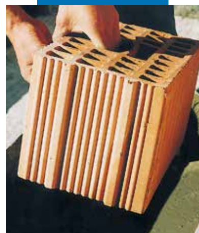
Układanie pustaków ceramicznych przy użyciu Adesilex P4
