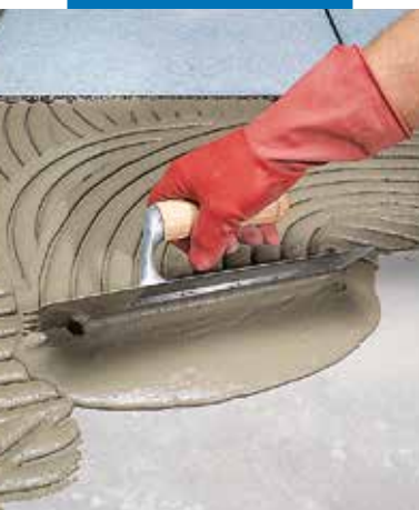
Rozprowadzenie gotowej zaprawy na podłożu za pomocą szpachli zębatej
