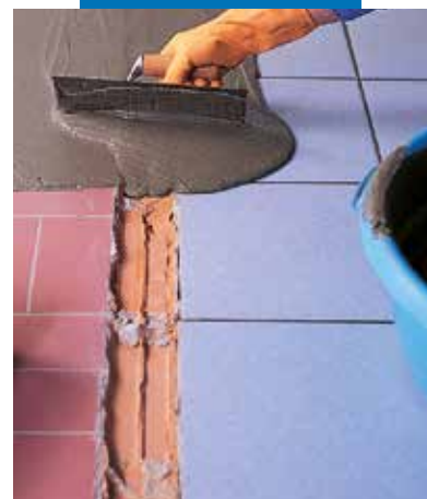
Wyrównanie istniejących podłoży ceramicznych przy użyciu Adesilex P4
