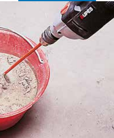
Przygotowanie zaprawy Adesilex P4
