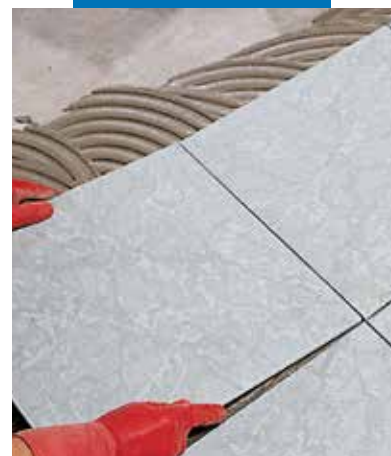
Mpntaż płytek z gresu porcelanowego
