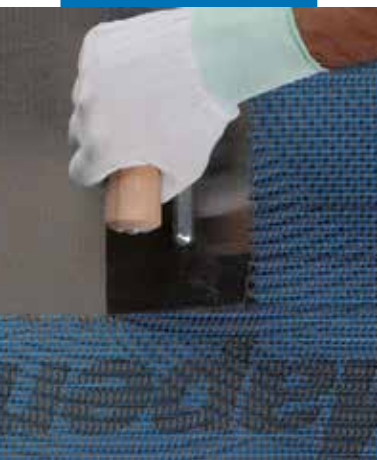
Wtapienie siatki Mapei 150 w warstwę zaprawy.
