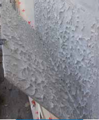
Optymalne wypełnienie spodniej strony płytki klejem
