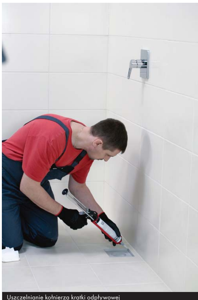
Uszczelnianie kołnierza kratki odpływowej
