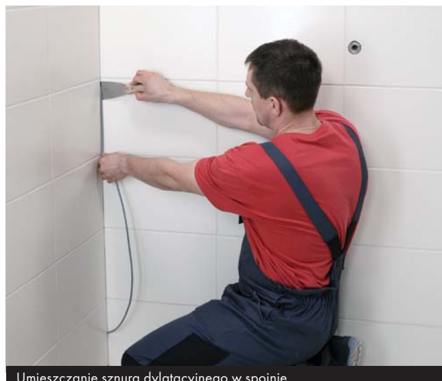
Umieszczanie sznura dylatacyjnego w spoinie
